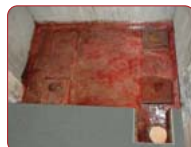
浴槽側床防水 (FRPブレイクライニング)
