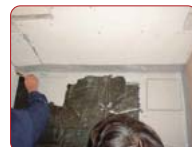
さらにFRPトップコート
