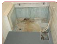
洗い場FRPパン取付
