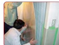
壁・天井パネル取付
